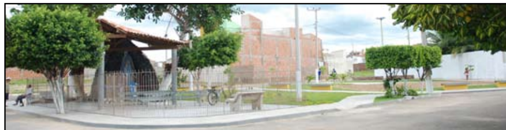
Praça tem área total de 657 metros quadrados
